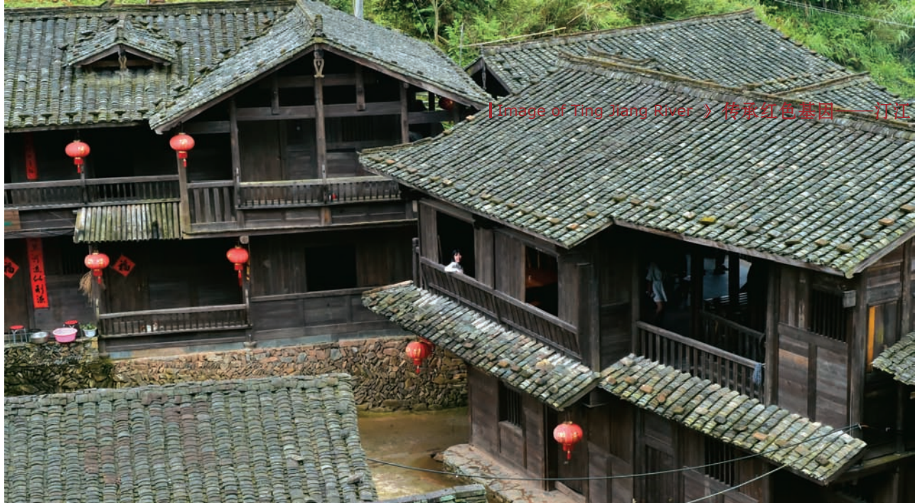
坐落于700米海拔上的丁屋岭，拥有800年历史，被誉为“客家先民生活的活化石”。百姓建房不用水泥，至今仍保留原始村落形态，黄泥墙、黑灰瓦、石台阶随处可见（陈扬富摄）
