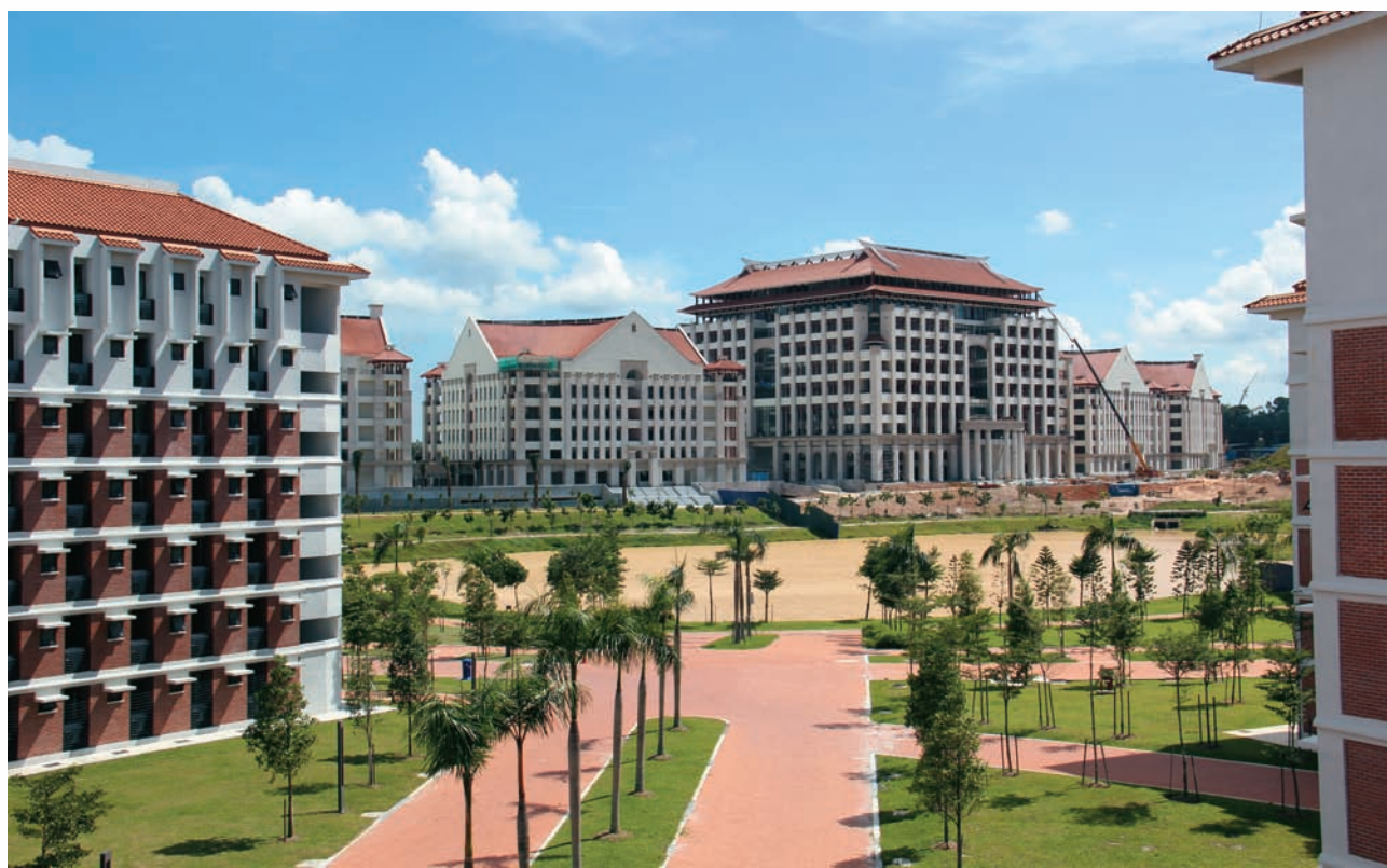
一期工程包括主教学楼群等共 13 栋建筑，将于 2017 年内全部竣工
